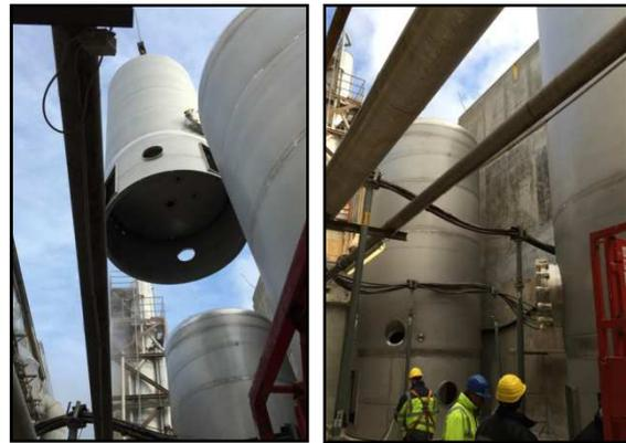
Abbildung 6: Hub und Installation von sechs 10-Tonnen schweren Behältern auf genau definierte Fundamente
